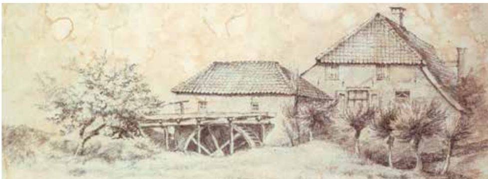
Afbeelding 1: Tekening uit 1857 van Maria Vos van de molen van Hooijer aan de Gielenbeek te Oosterbeek. In 2008 werd hier een vrij constante afvoer gemeten van 5 l/s, veel te weinig om deze molen aan te drijven; bij een overstorthoogte van 3 m bedroeg het netto-vermogen misschien 100 watt, voldoende voor een gloeilampje.
